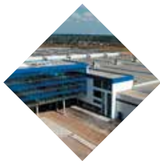
Завод по производству гофрокартона и гофротары «Архбум»
